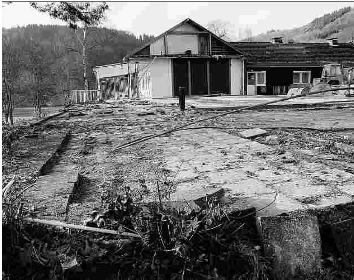
Der Antoniushof in Rurberg verändert sein Gesicht: Der alte Saalbau ist inzwischen abgerissen. An seine Stelle tritt ein vergrößerter Neubau. Fotos: P. Stollenwerk
