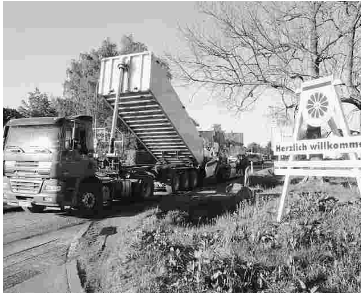
Zeitgleich wurden jetzt mehrere Straßenbau-Aktivitäten im Stadtgebiet Monschau gestartet. Auch der Ortseingang Imgenbroich auf der L 246 wird saniert. Foto: P. Stollenwerk
