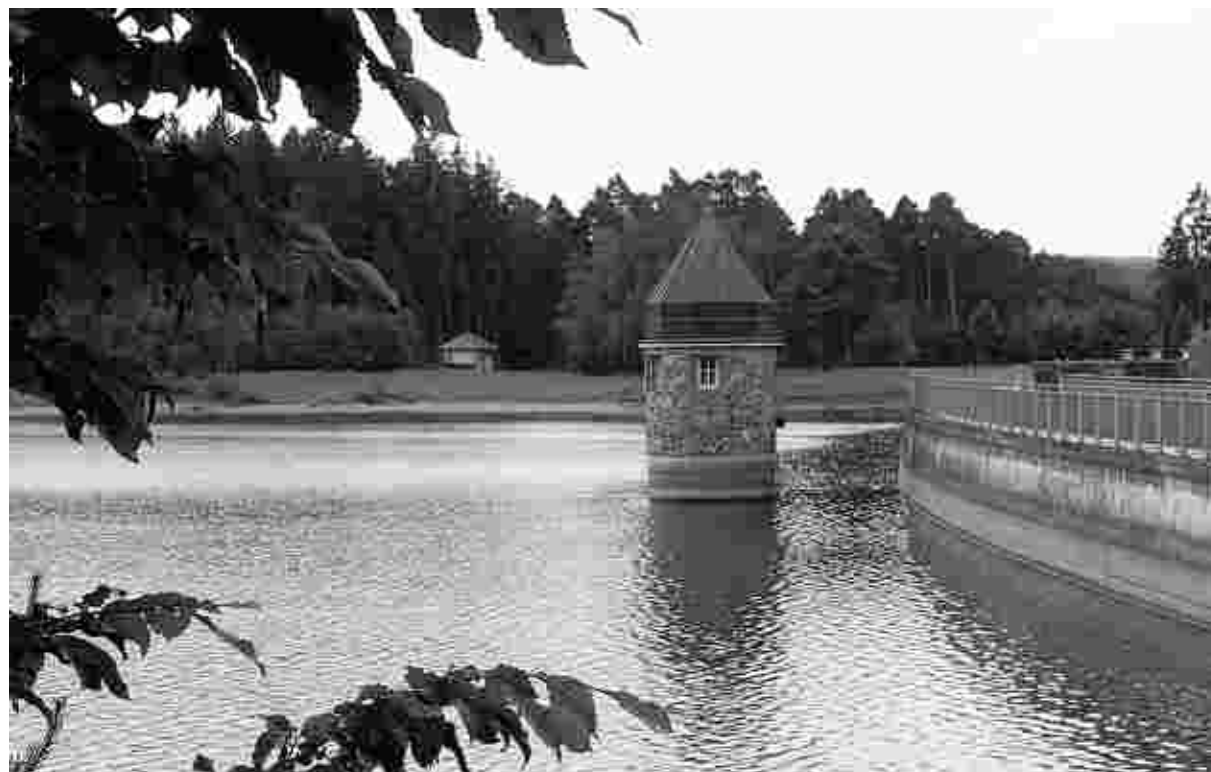
Die reizvolle landschaftliche Lage der Dreilägerbachtalsperre in Roetgen wollen die Ratsfraktionen nutzen, um Wanderer in die Eifelgemeinde zu locken. Für die zuvor erforderliche Aufhebung der Trinkwasserschutzzone I sehen WAG und Kreis Aachen allerdings kaum Chancen. Foto: P. Stollenwerk
