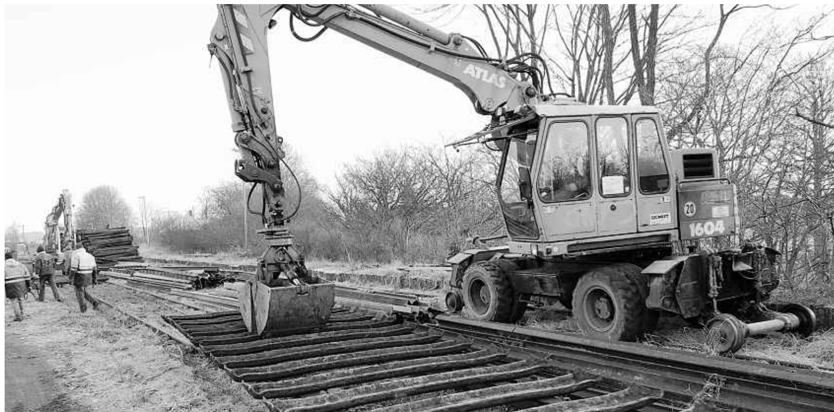
Demontage: In der Eifel werden die Schienen der alten Vennbahntrasse abgebaut, um Platz für Radfahrer zu machen.
