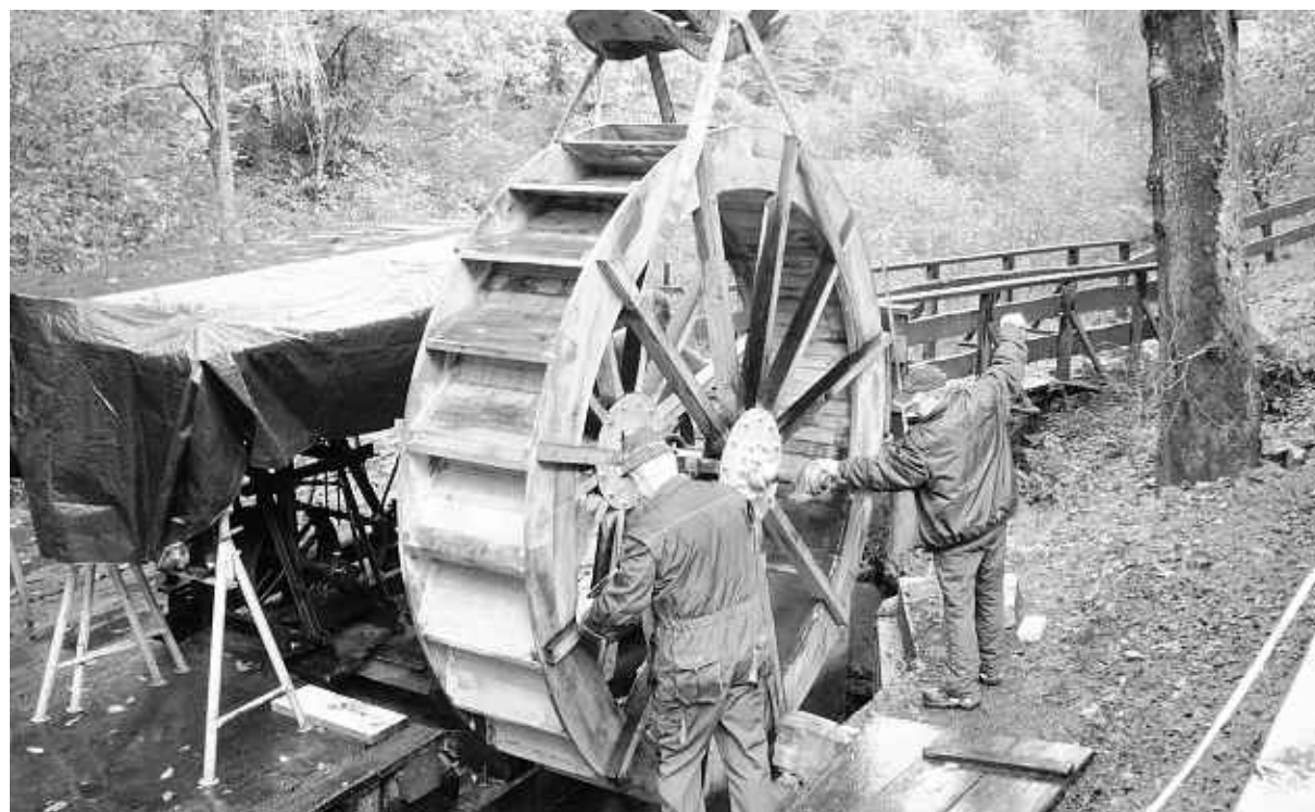
Filigranarbeit musste Manfred Huppertz im Holderbachtal leisten, um das neue Wasserrad mit seinem Kran vom Frontlader eines Traktors in den Schacht einzulassen. Foto: Franz Mertens
