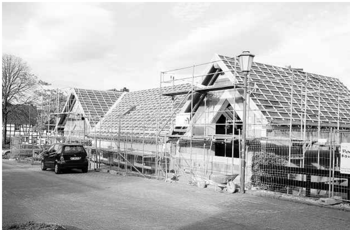
Knapp acht Wochen nach dem Spatenstich kann nun am neuen „Musik- und Kulturhaus“ in Konzen Richtfest gefeiert werden. Das 24 Meter lange und etwa neun Meter breite Haus auf dem Dorfplatz, gleich gegenüber der Grundschule, soll zur Kleinkirmes im nächsten Frühjahr fertig sein. Foto: dm
