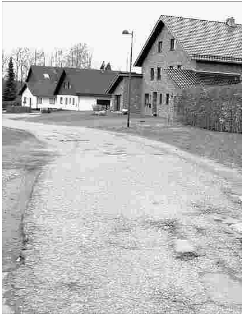
Auch die Erschließungsstraßen im Baugebiet „Mahr West“ in Simmerath sollen in diesem Jahr endgültig ausgebaut werden. Foto: K. Breuer
