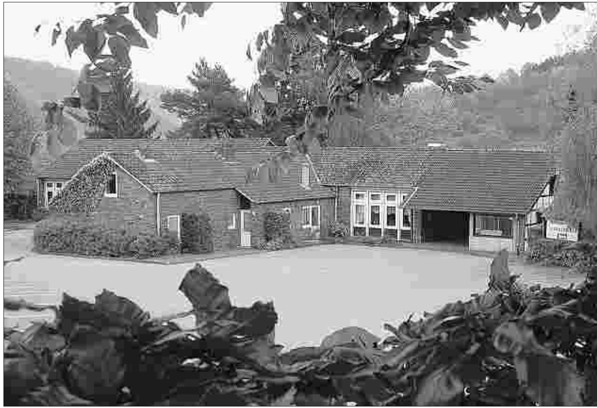
Der Saal im Rurberger Antoniushof wird abgerissen, ein neuer Saal, so der Wunsch der Dorfgemeinschaft, wird gebaut. Die Fenster sollen aber, so weit möglich, im neuen Saal verwertet werden. Foto: P. Stollenwerk
