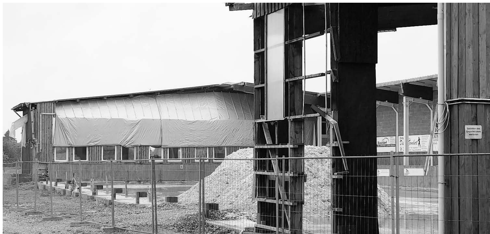
Baustelle statt Hindernisse: Die im vergangenen Winter unter Schneelast eingestürzte Reithalle des Reitvereins St. Georg Mützenich soll zum kommenden Winter wieder genutzt werden. Foto: P. Stollenwerk
