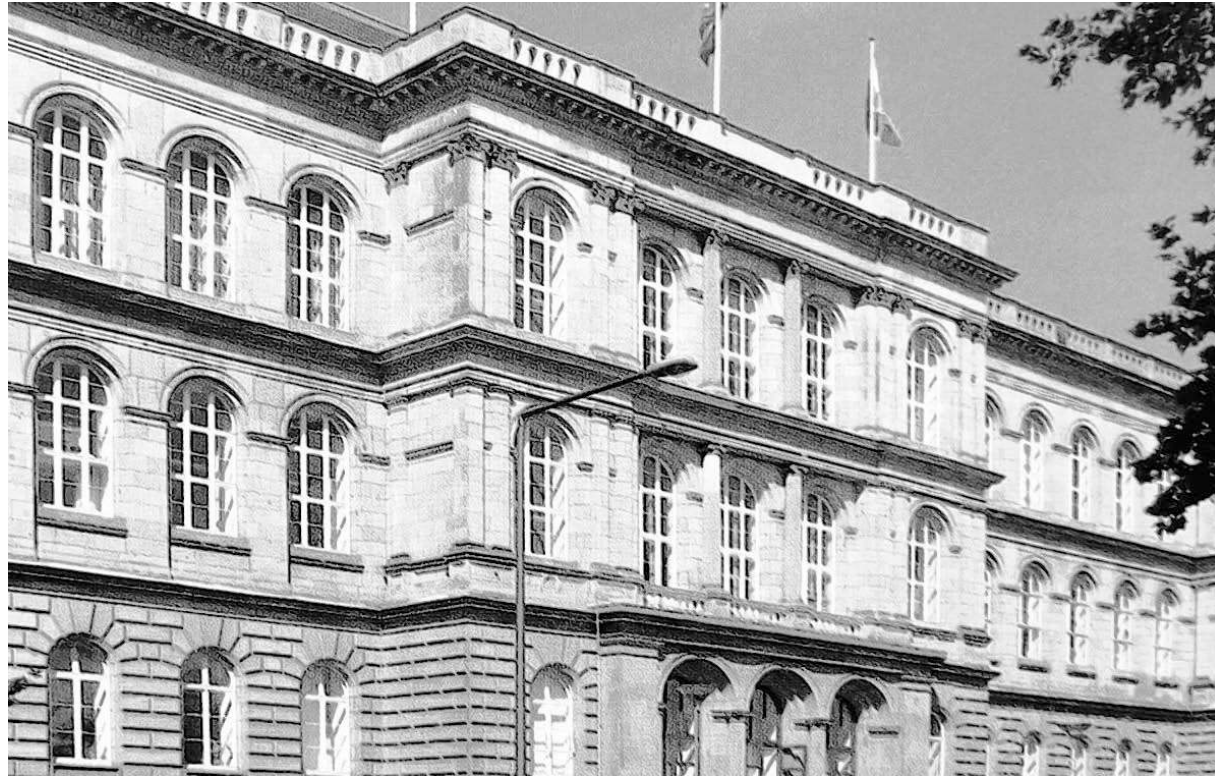
Aus Eifeler Gestein errichtet: Das massive Hauptgebäude der Rheinisch-Westfälischen Technischen Hochschule in Aachen.
