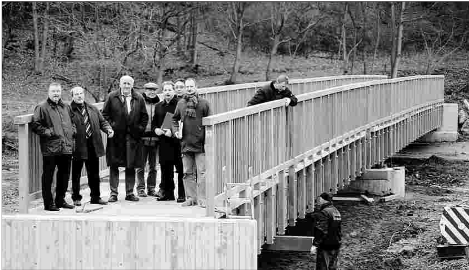
Während die Handwerker letzte Arbeiten an der neuen Brücke erledigten, inspizierten Vertreter von Kreis und Gemeinde den neuen Weg über die Rur, kurz nachdem die 60 Tonnen schwere Holz- und Stahlkonstruktion passgenau auf dem Betonunterbau aufgesetzt worden war. Foto: Heiner Schepp
