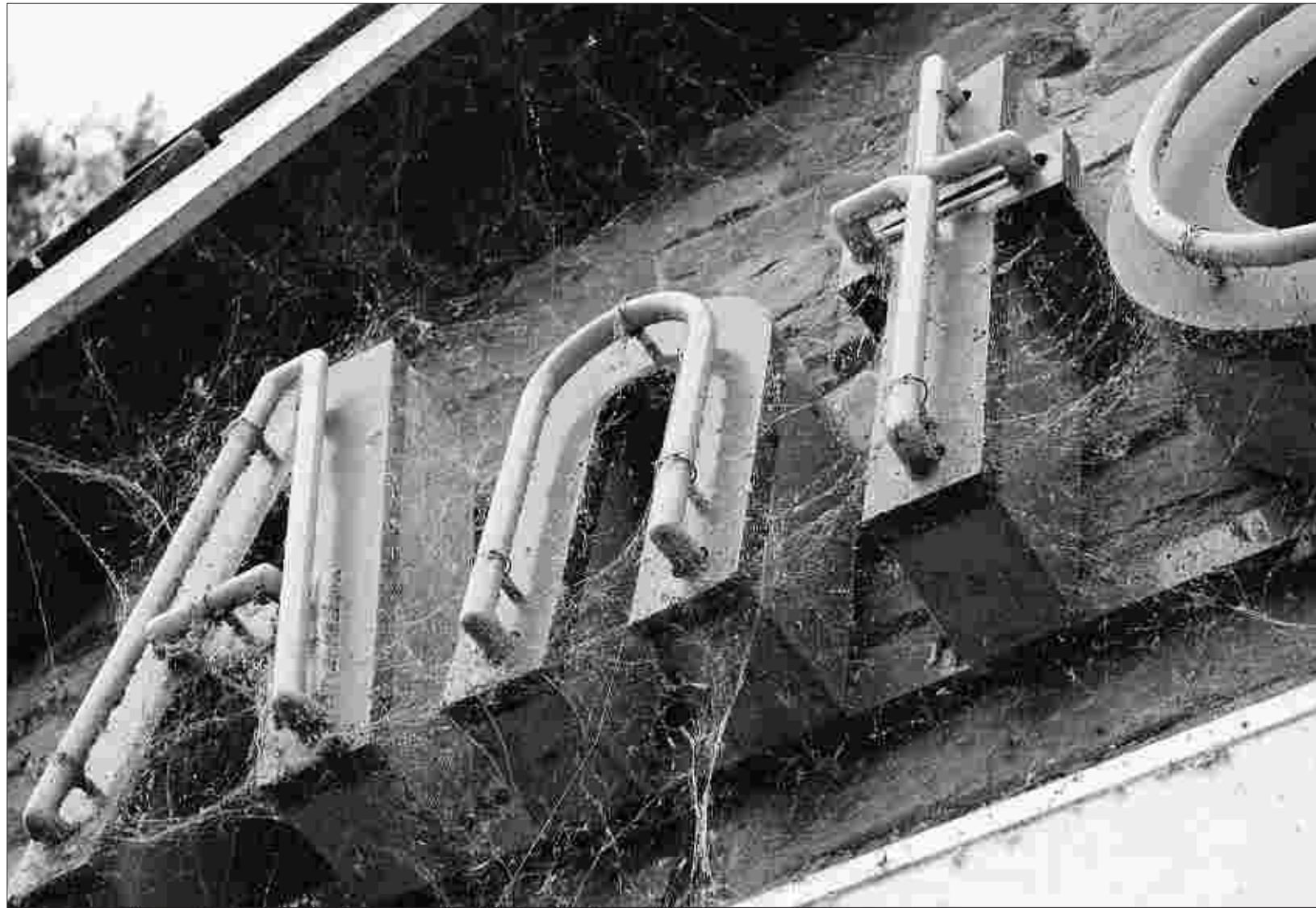
Im Gegensatz zum optischen gelungen aufbereiteten Rurseezentrum vermittelt der Antoniushof in Rurberg derzeit ein wenig Hinterhof-Atmosphäre. Teile des Gebäudes sollen abgerissen und erneuert werden. Foto: P. Stollenwerk
